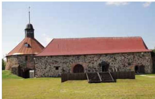
Корела после реставрации
